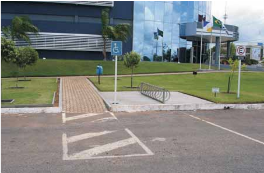
Foto 14: Exemplo de vaga demarcada para deficiente físico, com devida área de acesso lateral e guia rebaixada (Fonte: Francisco O. M. Amaral)
