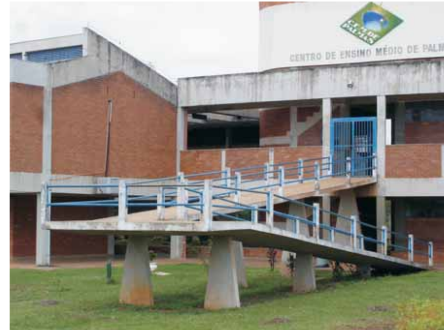
Foto 8: Exemplo de rampas de acesso a edifício público em Palmas. (Fonte: Arquivo de Francisco O. M. do Amaral)
