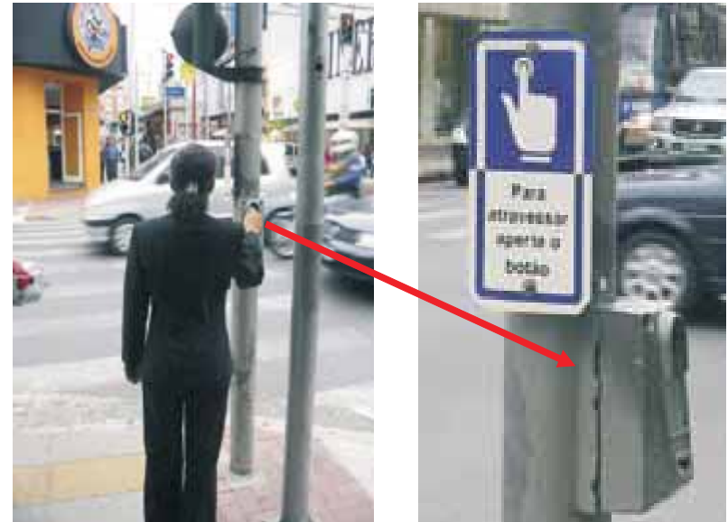
Fotos 9 e 10: Exemplo de boteeira junto à faixa de segurança. (Fonte: Brasil. Ministério das Cidades. Caderno do Programa Brasil Acessível)
